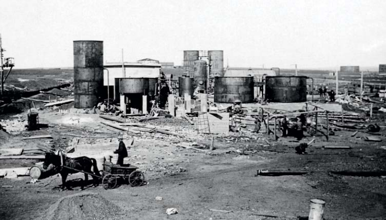
Строительство перегонных установок
