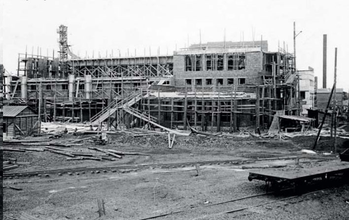
Строительство здания заводской лаборатории
